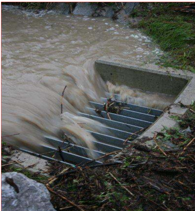
Die Verklausung dieser Bachfassung war der Auslöser
