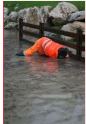
Öffnen des Oberflächenkanales
