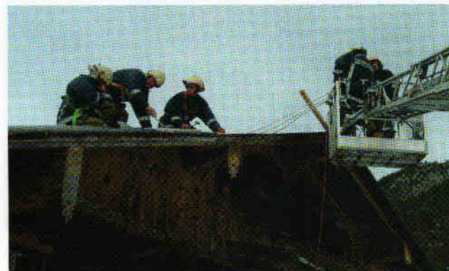
28. Dez. – 11.15 Uhr / Dachsicherung nach Sturm in Buchau.
